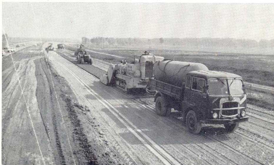
Фиг. 9.2. Заздравяване на почва в пътно строителство чрез смесване на място
