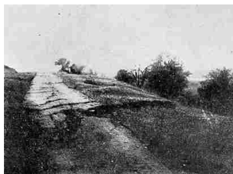
Фиг. 3. Нарушенията на Цариградското шосе (сега главен път Е-80) близо до Поповица показват повърхностната изява на разлома при земетресението на 18 април 1928 г. (ДИПОЗЕ, 1931).
